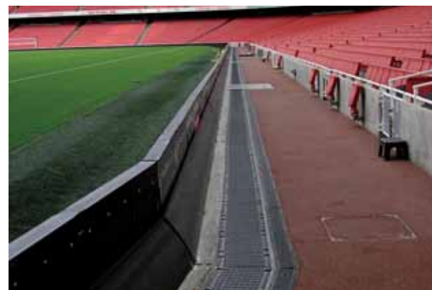
Стадион команды Arsenal «FC Emirate», Лондон с сервисными каналами ХАУРАТОН
