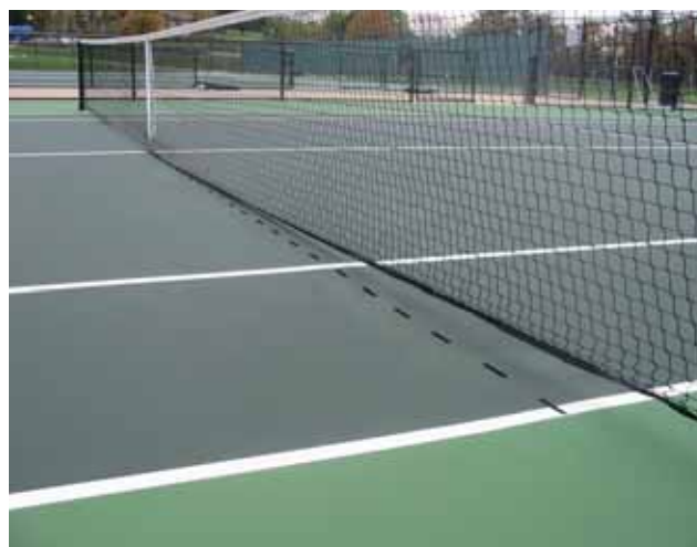
Щелевые каналы в середине поля
